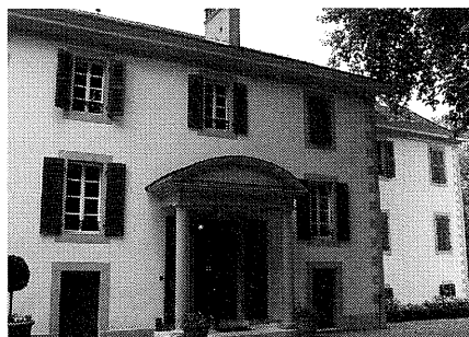
(写真) 本棟正面玄関
