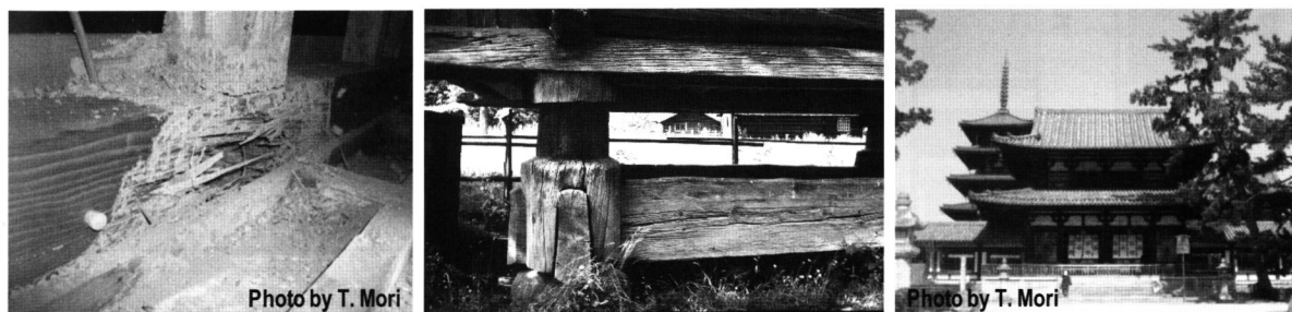
図1：木材の生物劣化、風化、老化（左：シロアリおよび腐朽菌による劣化、中央：風化、右：法隆寺部材の老化）
