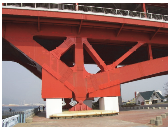
写真 4.1 中間支承の段差防止構造例
