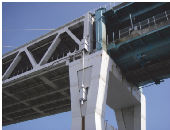
写真 3.2 端橋脚アップリフト防止構造案例
