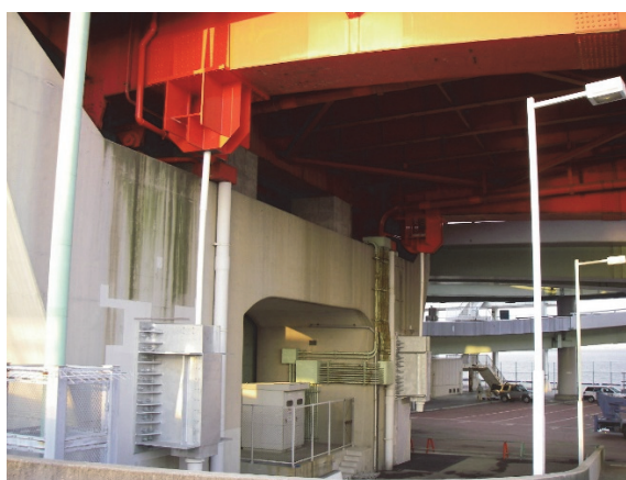
写真 4.2 ペンデル支承のアップリフト防止構造例
