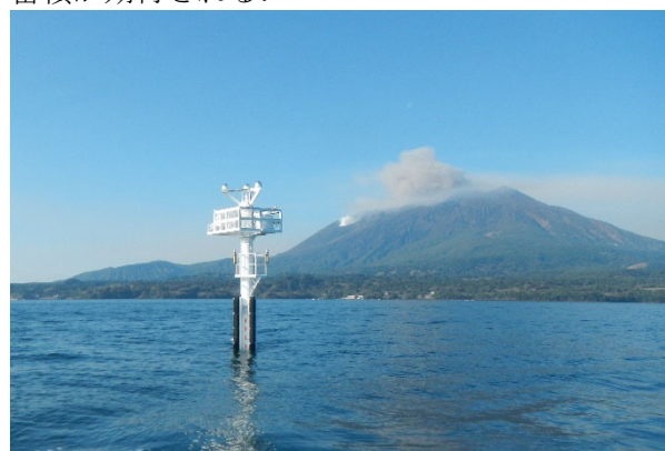
海底地盤変動観測装置
