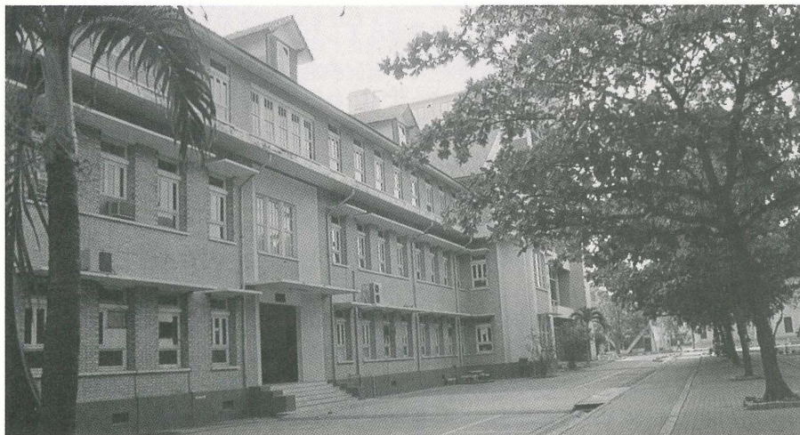
チュラロンコーン大学工学部共同講義室棟
