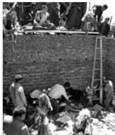
写真1 集められた大量の供物は、工所用エレベーターで次々と運び上げられ、チオルテン内部に投入される。
