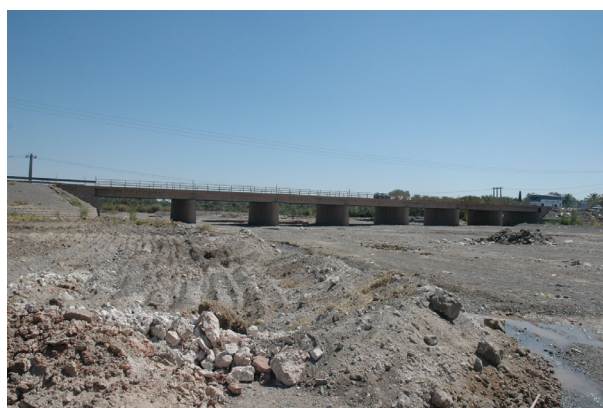
写真 4 観測点4：弾性波探査実施地点(Bridge 3)
