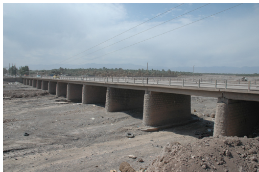
写真 2 観測点2: 弾性波探査実施地点(Bridge 1)
