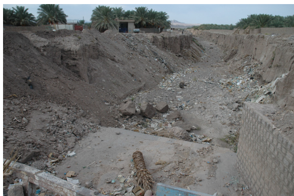
写真 3 観測点3：弾性波探査実施地点(Bridge 2)
