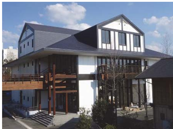
木質材料実験棟
