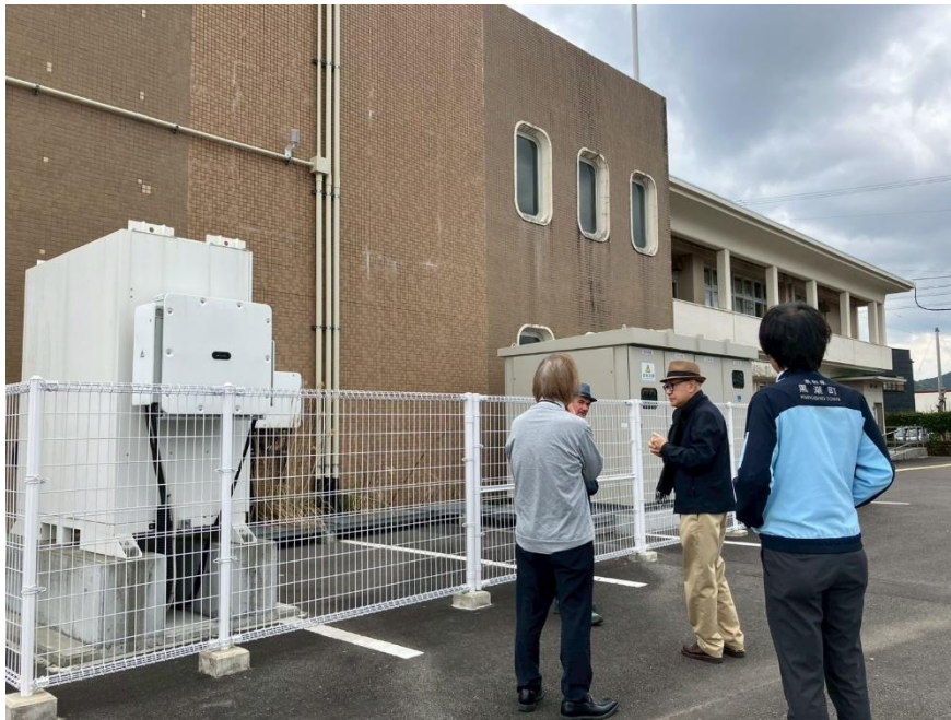
図 6 ZEB(ゼロエミッション)化された庁舎建物(高知県黒潮町)
