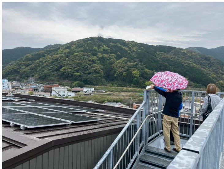
図 7 新たに太陽光パネルが設置された避難タワー(高知県黒潮町)
