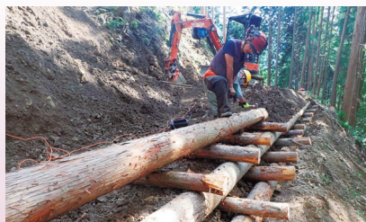
木組による作業道補修 （和歌山研究林）
