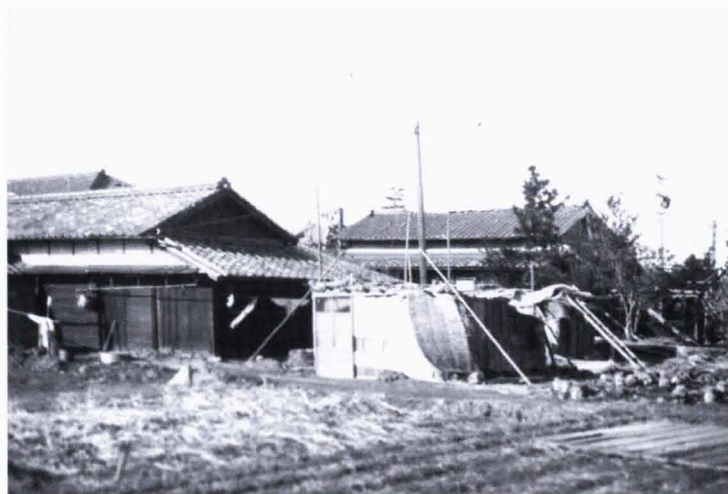
図6 余震が激しかったため自宅が倒壊していなくても仮設の地震小屋に避難した (宮村攝三、元東京大学地震研究所教授が撮影し保管していた写真)
