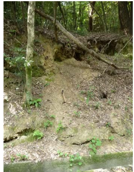
写真2 強風化して崩壊している丹波層群
