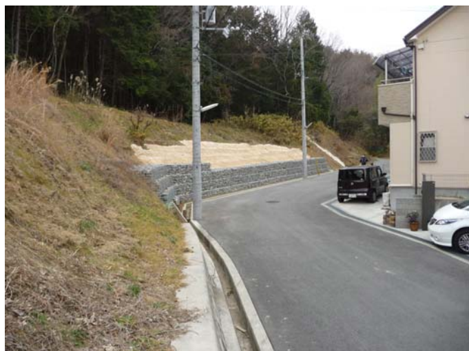
写真3 対策工完了状況
