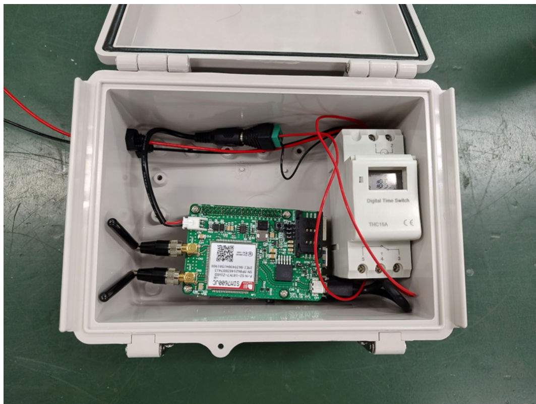
写真 2. 観測用ボックス収納状況
