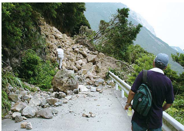
写真-3 地すべりで塞がれた神津島の道路 (撮影・加藤照之：東京大学地震研究所)
