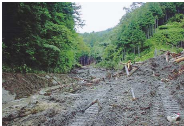
写真-7 岐阜県上矢作町飯田洞。土石流と思われる。 2000/09/16.
