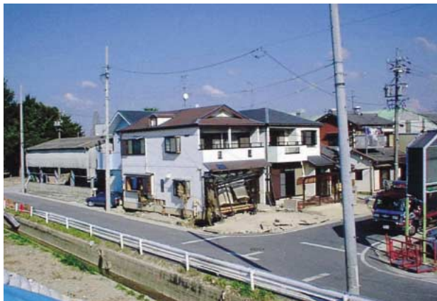
写真-3 名古屋市西区あし原町。新川破堤箇所直面に民家の破損状況。2000/10/04。
