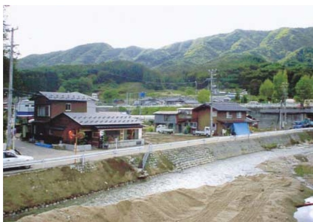
写真-8 長野県平谷村役場付近の被災後解体された家屋跡。 2000/10/09.
