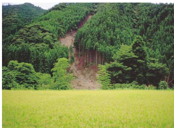
写真-6 岐阜県上矢作町久武瀬。斜面崩壊。2000/09/16。
