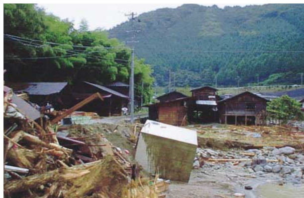
写真-5 岐阜県上矢作町本郷。矢作川の浸食による家屋の損壊。2000/09/16。
