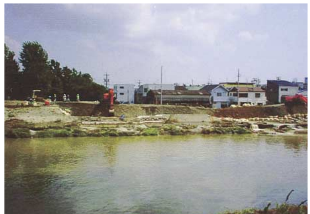
写真-2 名古屋市西区あし原町。新川左岸破堤箇所の復旧作業状況。2000/09/13。
