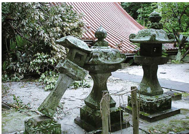
写真-4 神津島の倒れた石灯籠と崩壊した神社 (撮影・加藤照之：東京大学地震研究所)
