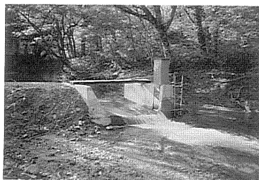
写真2 上谷量水堰 Photo 2 Kamitani weir
