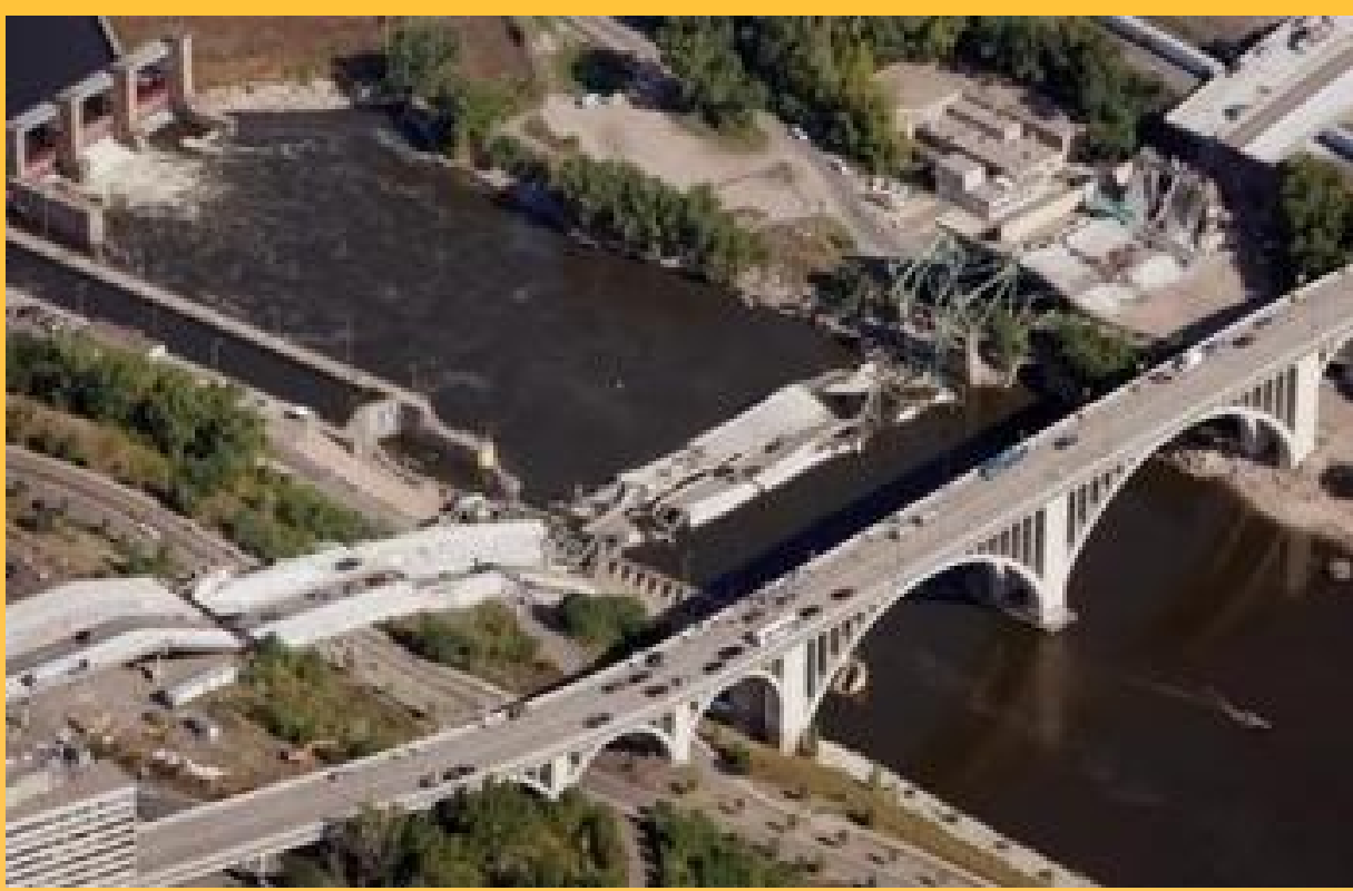
ミシシッピ川I-35W橋崩落事故
