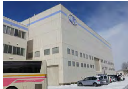
写真-1 風洞技術センターの外観
