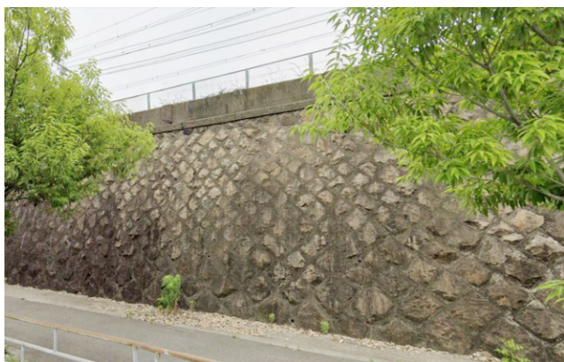
図2 鉄道盛土の石積み壁
