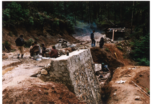
写真4 BRO 道路工事現場 (AP)
