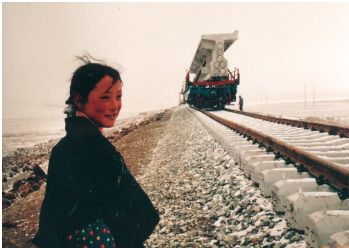
写真1 青蔵鉄道の建設
