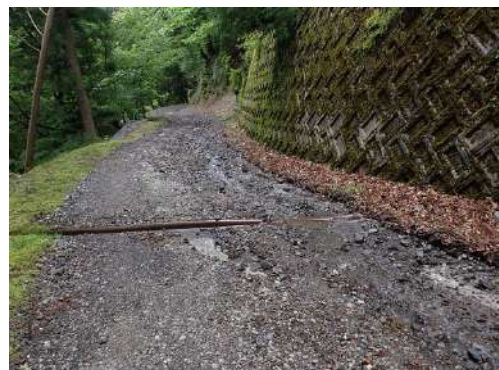
図 2 鋼製 U 字溝
