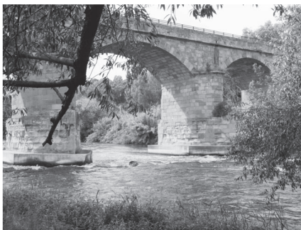
（写真5）ティルソ川とローマ時代の橋
