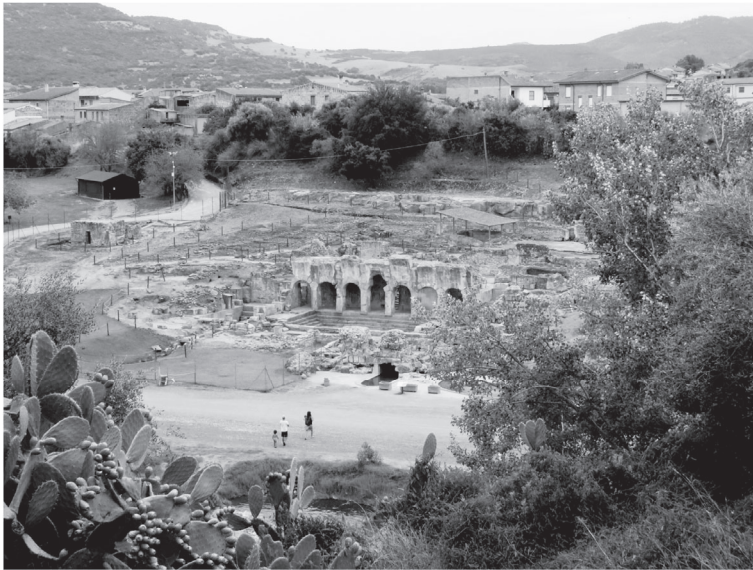
(写真1) フォルドンジアヌス遠景 (手前が公共浴場の遺構。奥が現在の市街地)
