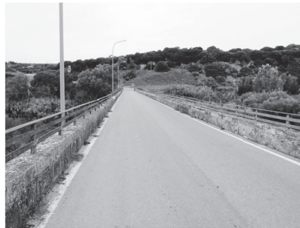
（写真7）橋上から北方を望む
