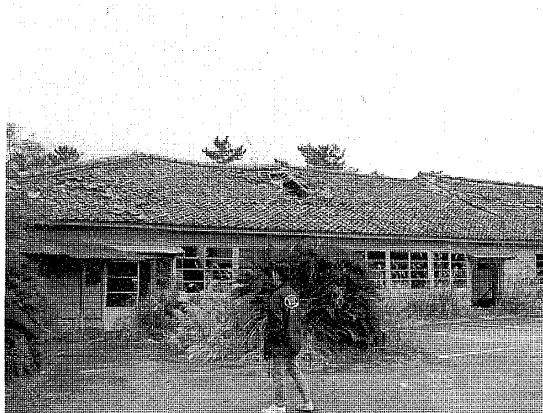
図2 壁内部から屋根組みの木材にまでイエシロアリによる激しい被害を受けた廃屋
