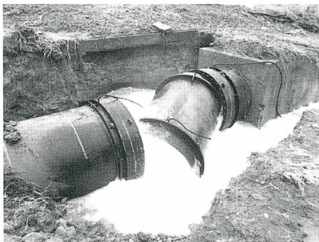
図1 東日本大震災における伸縮管の破損・脱管被害事例 (提供：宮城県ホームページ)
