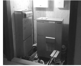
図 10 燃料電池システムの設置
