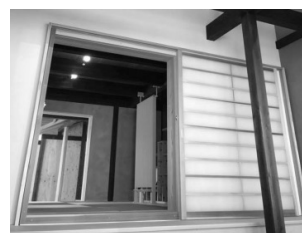
図7 土間に面したエアロゲル建具
