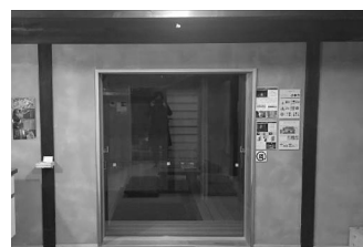
図5 中塗り仕上げの南壁
