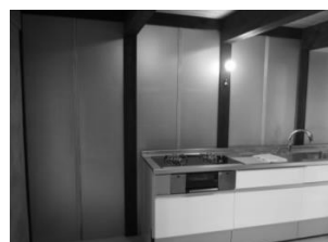
図4 内張りした真空断熱材パネル
