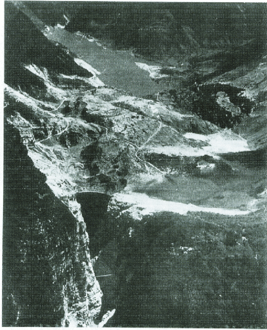
図-5 崩壊後のバイオントダム
