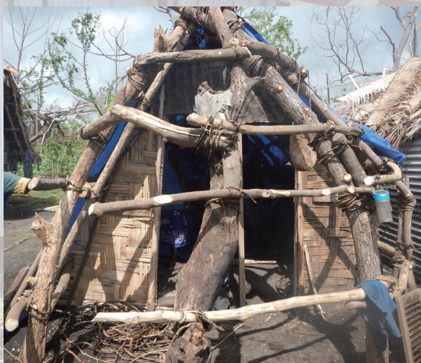
【写真3】建設中の伝統的サイクロンシェルター
