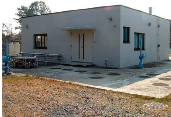
図1 実験排水処理施設
