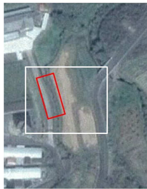
写真-2 崩落前現場航空写真
