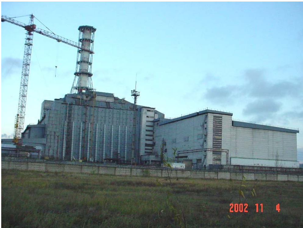
破壊された4号炉を覆う石棺(2002年11月)
