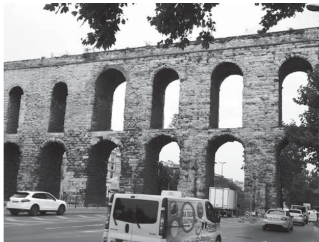
【写真①ヴァレンス水道橋南面】
