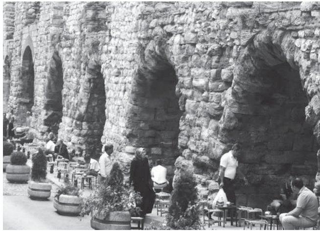
【写真⑭アーチ下のチャイハネ（水道橋北面）】
