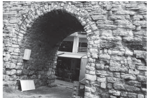
【写真⑪下層のアーチ内に置かれた生活用品】
