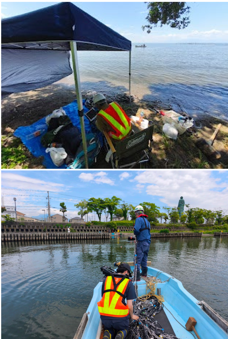
図-8 水中表面波探査の状況，下がハイドロフォンの敷設作業
