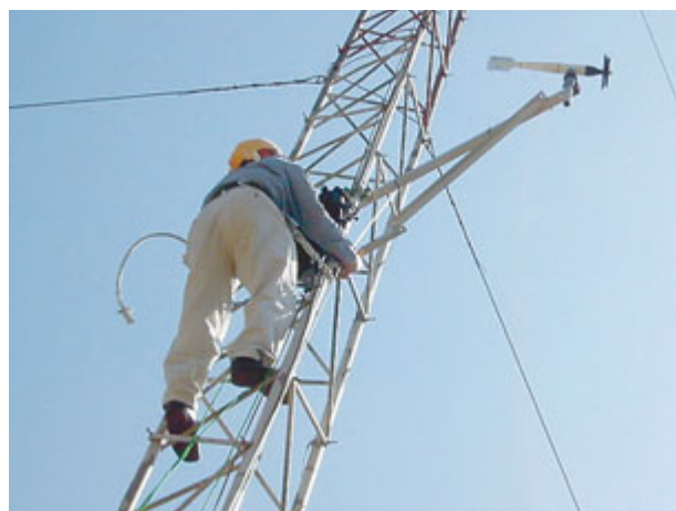
自動気象観測装置の取り付け
