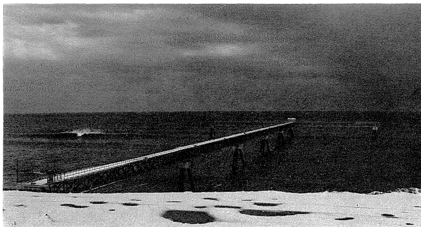
写真-2・35 T型波浪・漂砂観測用栈橋全景
