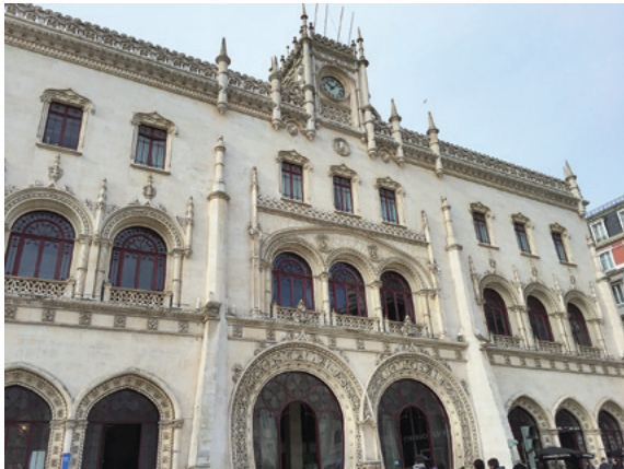
写真3 現在のリスボン中央駅。設計当時の姿(写真2)をほとんどそのままに見ることができる。 2017.02.12 筆者撮影
