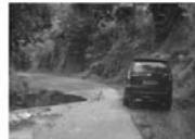
②雨水による土砂崩れで路肩が崩れた道路
