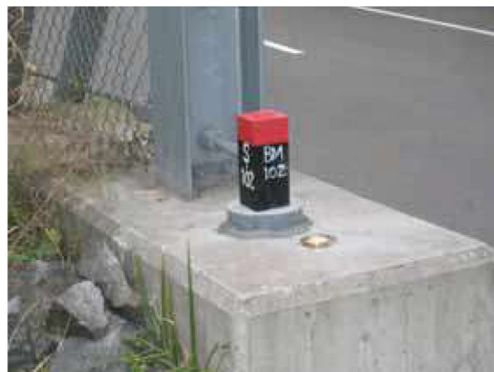
写真 3 新水準点の設置
