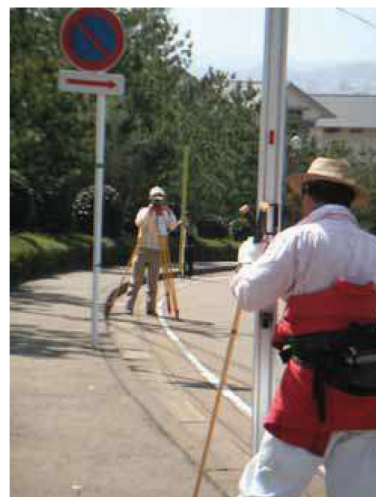
写真 1 水準測量風景
