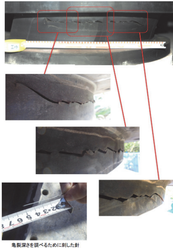
図-3 As1橋台G1支承の亀裂
