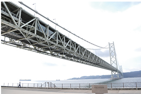
図1 明石海峡大橋
