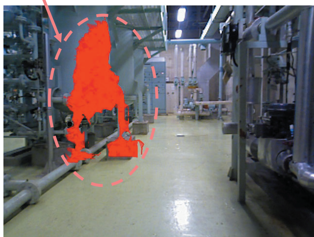
図4 拡張現実感を用いた干渉箇所の重畳表示の例
