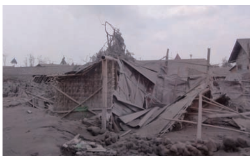
写真4 火山灰の堆積により崩壊した住宅
