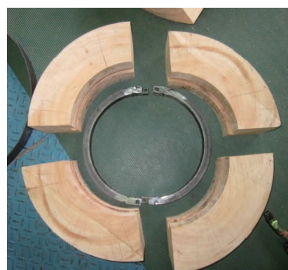
図3 補強のため分割された柱
