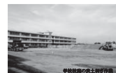
学校施設の敷土削ぎ作業
