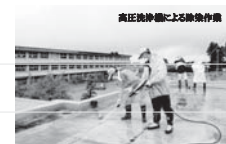
高圧洗浄機による除染作業
