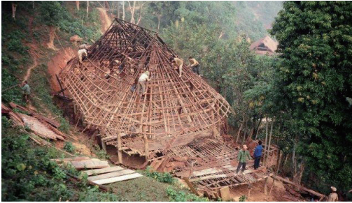
写真4 「亀の甲」型の家の解体
