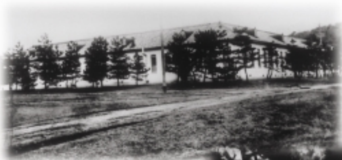
理工科大学純正化学教室本館
