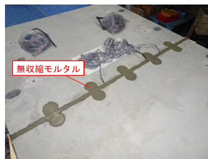
図 1-5 無収縮モルタル充填後の写真
