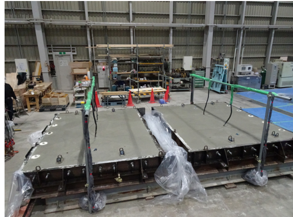
(b) コンクリート打込み完了
