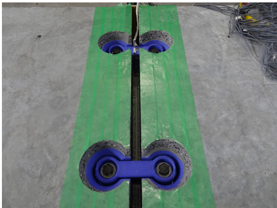
ブリッジによる接合完了
