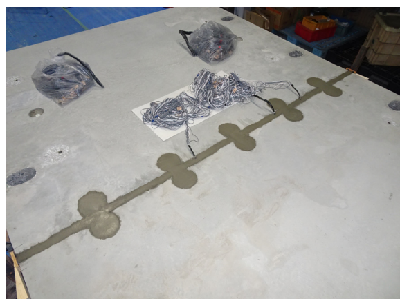
(f) モルタル打込み完了
