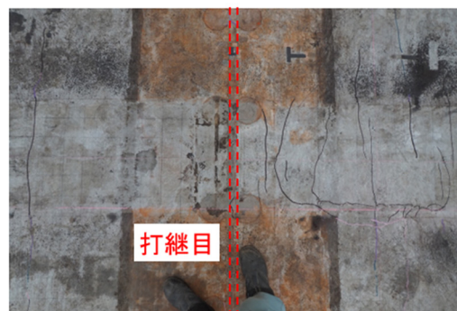
(a) 床版上面の打継目付近
