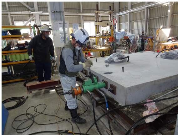
(c) PC 鋼棒緊張状況
