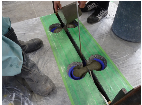
間詰め部のモルタル充填状況
