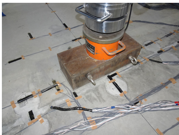
(c) 載荷板設置状況
