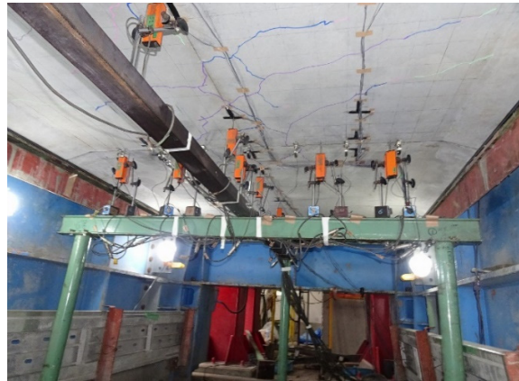
(b) 床版下面全景
