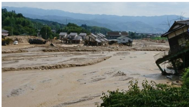
写真1 氾濫した赤谷川
