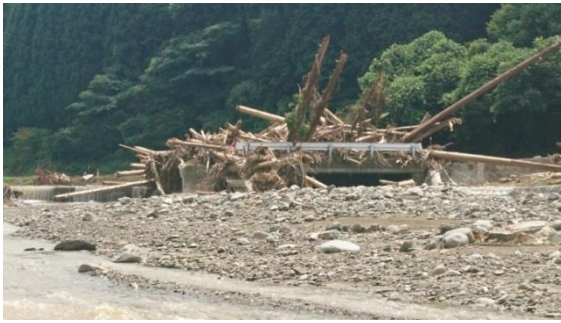
写真3 流木で閉塞した橋梁（寺内ダム上流黒川）
