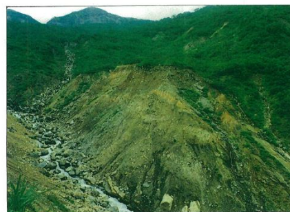
ホー14崩壊地の施工前の状況 湯の谷本流の浸食を受け崩壊土砂の発生源となっていた
