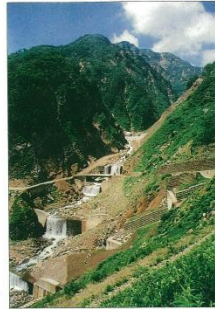
溪間工の施工（本流24号～27号）
