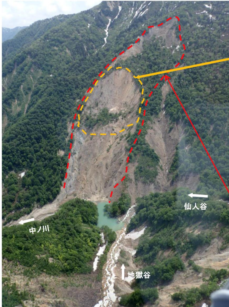
崩壊地正面の状況
