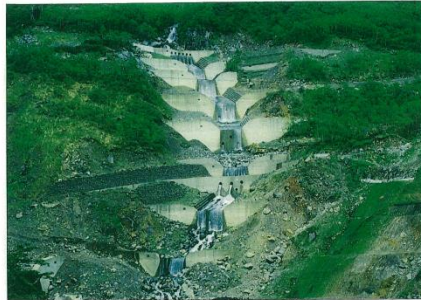
同左堂室谷（A谷）の合止工完成の状況
