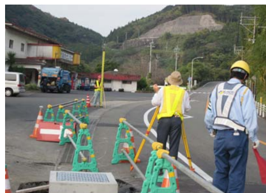
写真 3 水準点移設接続測定
