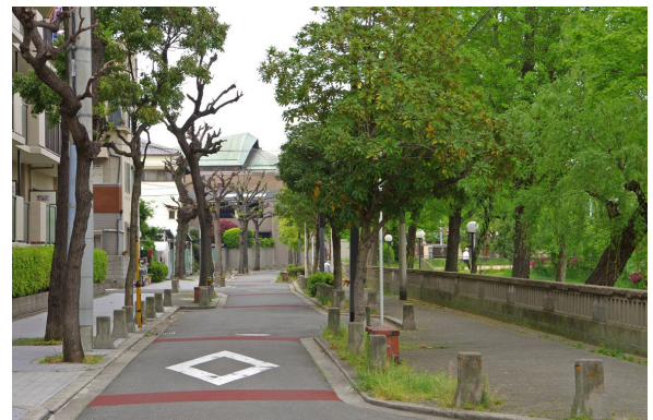
写真2 コミュニティ道路(長池西岸)の現況
