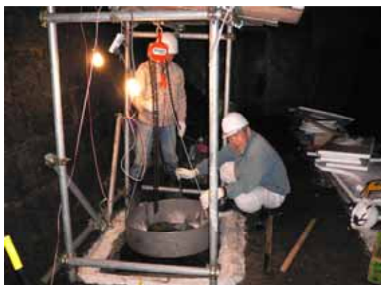
写真11：掘削穴へのひずみ計の設置
