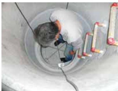
写真 20：狭いスペースでの 取り付け作業
