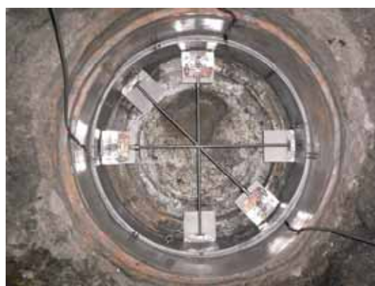
写真12：ひずみ計設置状況
