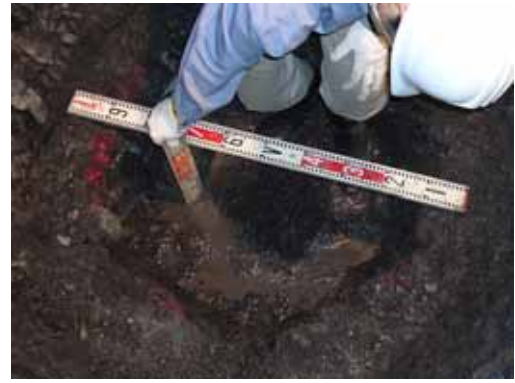
写真 15：ひずみ計設置穴
