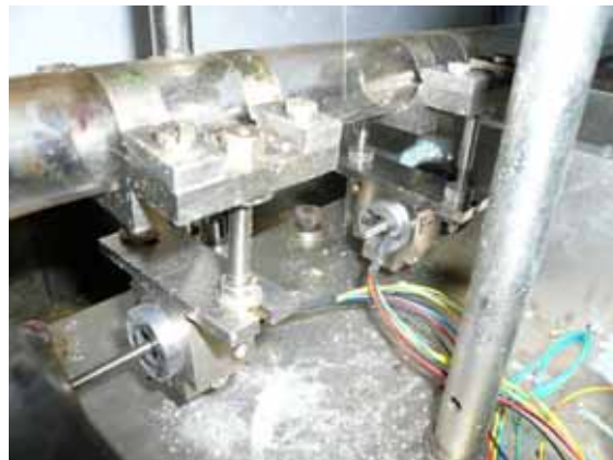
写真 4：改良前取り付け状況
