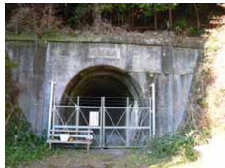
写真 13：高尾トンネル
