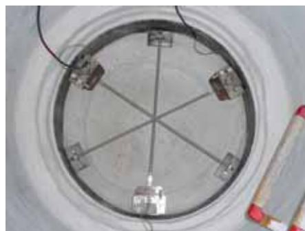
写真 21：三成分ひずみ計と 塗り固めた防水樹脂
