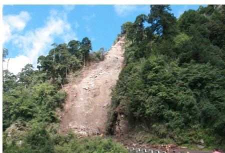
写真 26 地すべり現場
