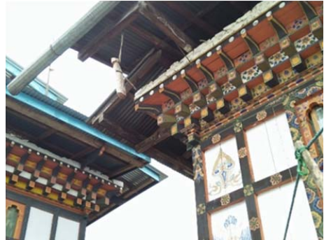
写真 18 屋根の角にぶら下がっているのが厄除け（ポー）
