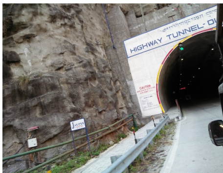
写真7 ブータン唯一の車道トンネル
